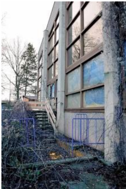
Eine Bauruine: das Taunusbad. Innen haben Arbeiter mit dem Abriss begonnen. Foto: nie
