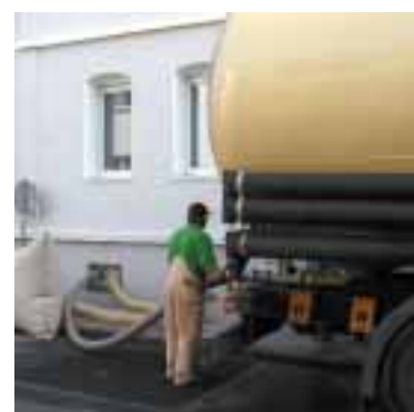
Die Pellets werden wie Heizöl im Tankwagen angeliefert.
