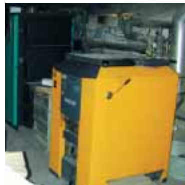
Der Stückholzkessel als unterstützende Komponente des Heizungssystems.
