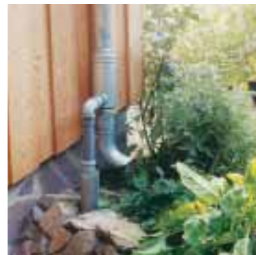
Regenwasser wird zur Versorgung von Waschmaschine und Toilette abgezweigt.
