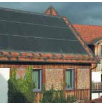
Mit Hilfe von thermischen Solaranlagen lässt sich die Sonnenenergie zur Erwärmung von Wasser und zur Heizungsunterstützung nutzen.
