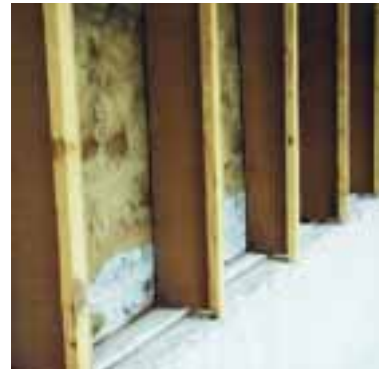
Im Außenwandbereich kommen dünne und damit wärmebrückenminimierte Trägerprofile zum Einsatz. Nach Abdeckung mit Holzfaserdämmplatten nehmen sie die Zelloosedämmung auf.
