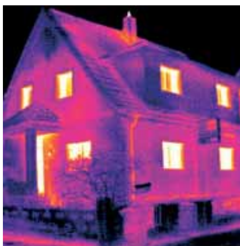
links: Dämmung der Gauben rechts: Thermogramm
