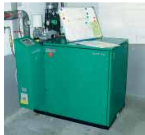
Blockheizkraftwerke nutzen den Brennstoff primärenergetisch sehr gut aus, indem sie gleichzeitig Wärme und Strom erzeugen.
