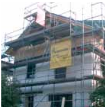
Umbau in Offenbach ZFH
