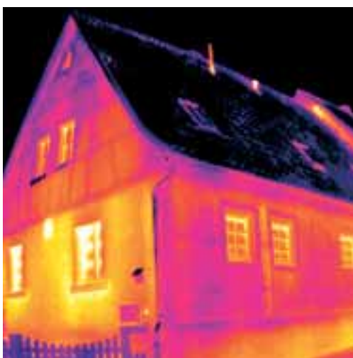
Thermogramm Straßenseite / Giebel
