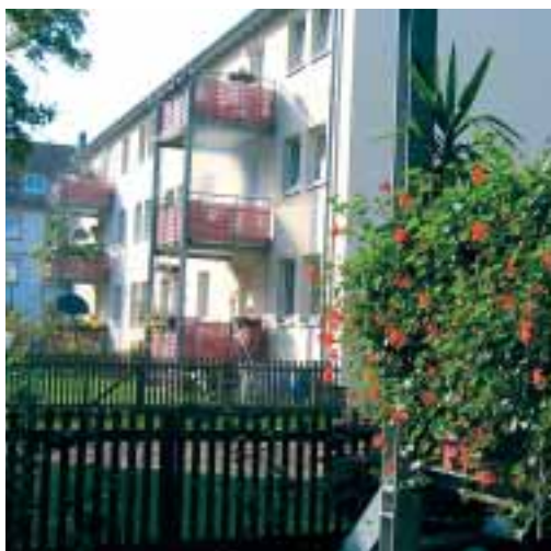
Der niedrige Heizwärmebedarf wird aus einer separaten Heizzentrale mit Nahwärme gedeckt.
