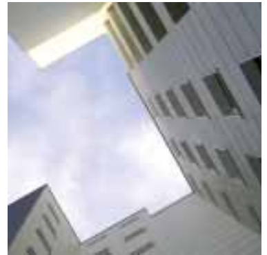
Die Fassade wurde mit großformatigen Eternittafeln verkleidet.
