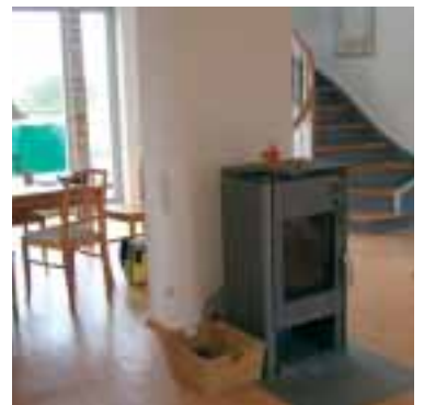
Im Wohnbereich steht ein Holz befeuerter Einzelofen als Zusatzheizung für die Übergangszeit.
