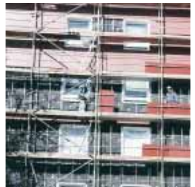
Die Stahlbeton-Außenwände wurden mit 8-12 cm verbesserter Mineralfaser gedämmt und anschließend mit Eternittafeln verkleidet.
