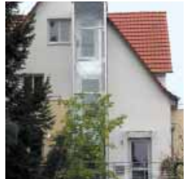
Über den im Eingangsbereich angebrachten Aufzug sind alle vier Ebenen des Hauses barrierefrei zu erreichen.
