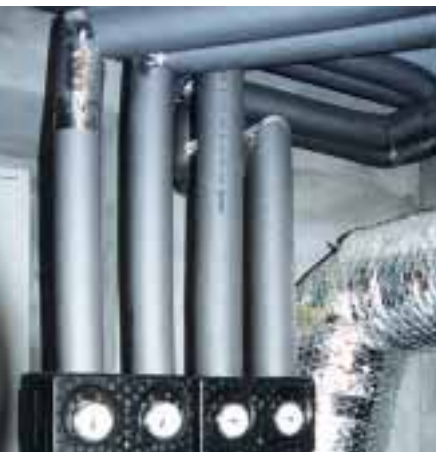
Frei verlegte Rohrleitungen müssen nachträglich gedämmt werden.
