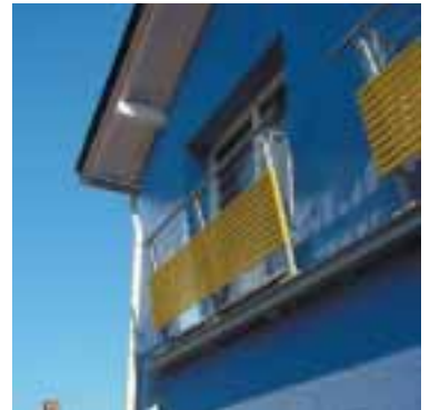
Im Zuge der Außenwanddämmung wurde auch der Dachüberstand angepasst.
