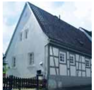
Das straßenseitige Sichtfachwerk wurde restauriert. Innen schützt eine 10 cm starke Mineralfaserdämmung vor Wärmeverlusten.
