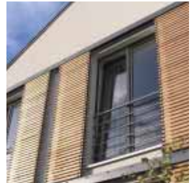
Die Verschattungseinrichtung aus hölzernen Lamellen wird automatisch gesteuert.
