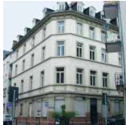
Bei denkmalgeschützten Fassaden kann der Heizenergieverbrauch durch eine Innendämmung gesenkt werden.
