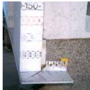
Das WDVS wurde bis 30 cm unter die Kellerdecke ausgeführt, um den Wärmebrückeneffekt über die Kellerwand zu reduzieren.
