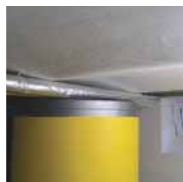
Unterseitige Dämmung der gewölbten Kellerdecke.
