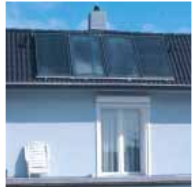
Flachkollektoren unterstützen die solare Warmwasserbereitung.
