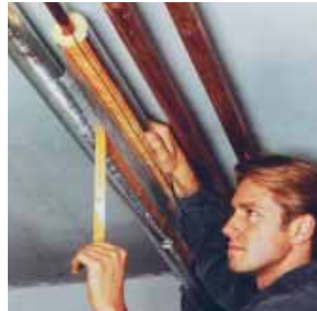
Ungedämmte Rohrleitungen in unbeheizten Räumen müssen gedämmt werden.
